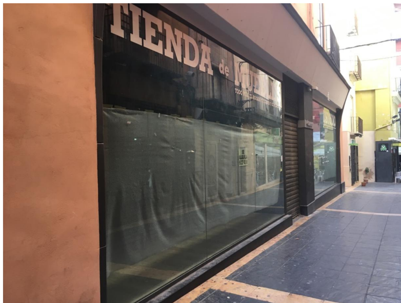
Fachada principal del local.
