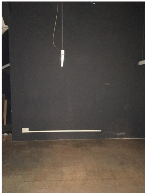
Zona entre local parte delantera y almacén.
