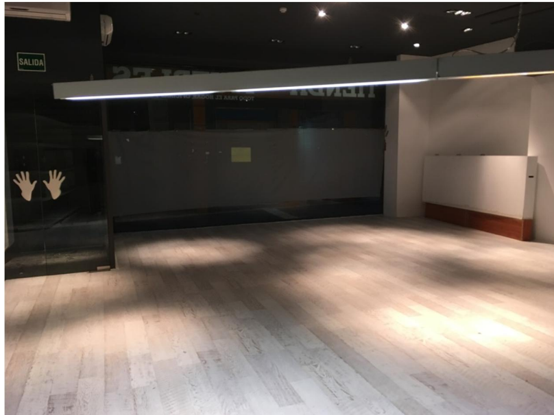
Parte del local recayente a c/Botigues.
