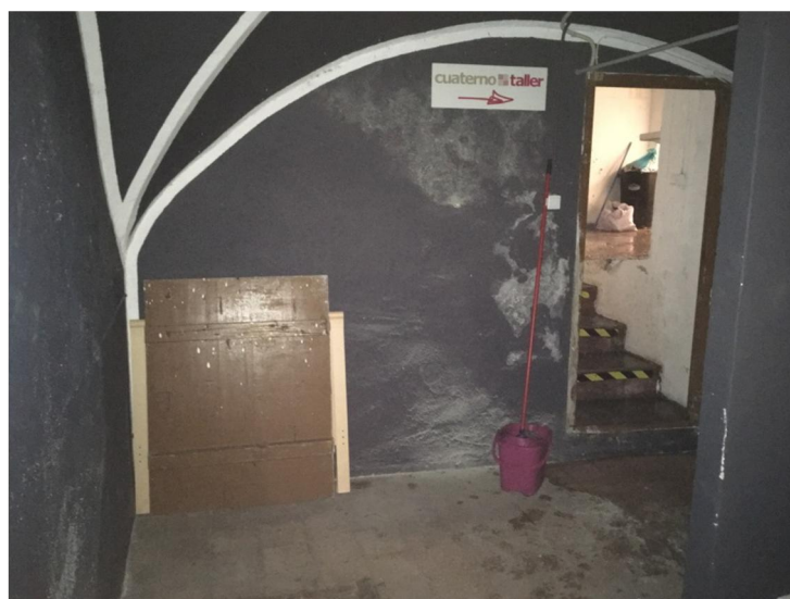
Zona entre local parte delantera y almacén.
